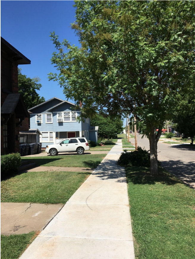
New sidewalks & ADA ramps
